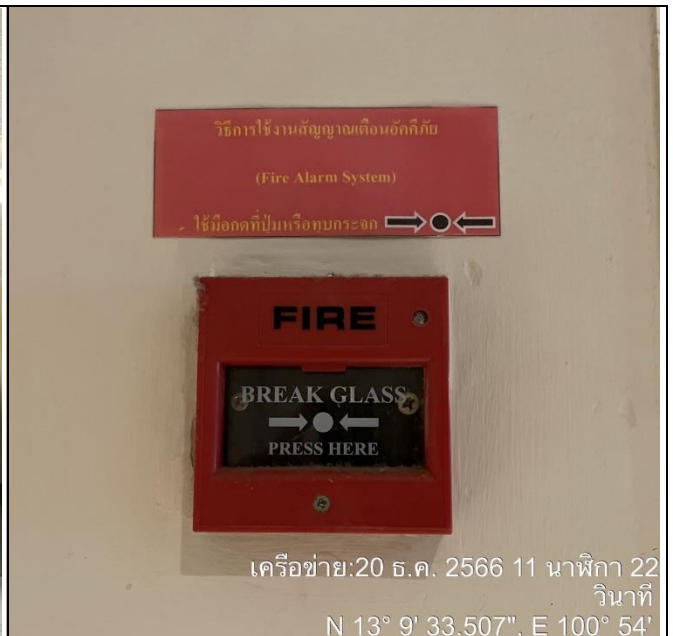
รูปที่ 2.4.7.2-2 อุปกรณ์เตือนภัยโดยมือกด (Manual Station)
