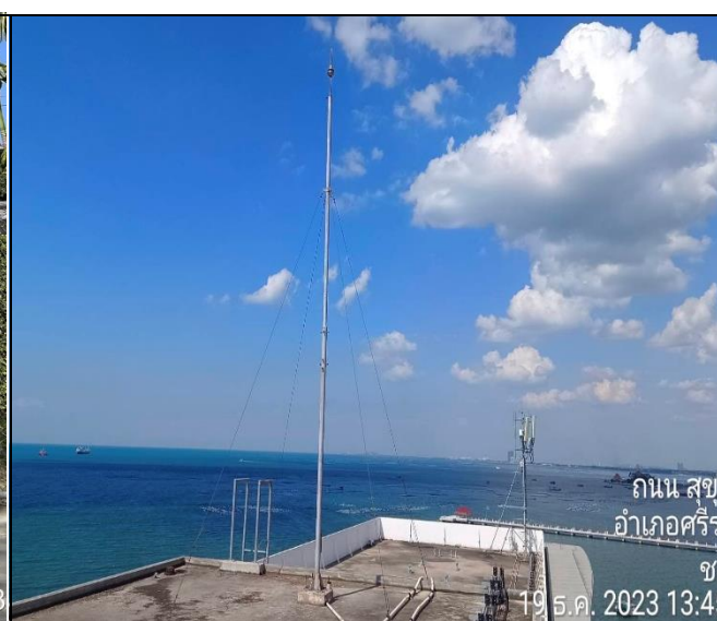
รูปที่ 2.4.6-2 ระบบป้องกันอันตรายจากฟ้าผ่า
