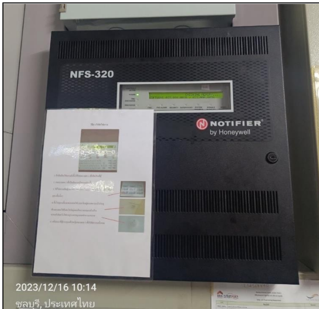
รูปที่ 2.4.7.2-1 แผงควบคุม (FCP)
